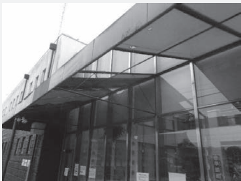
町民総合会館 テント屋根
